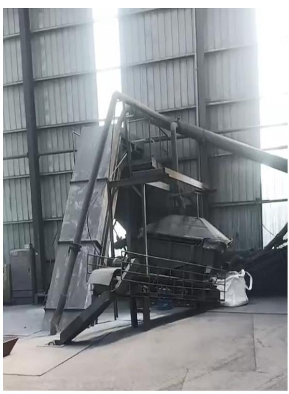
2#破碎车间进料口集气罩及集气管道
